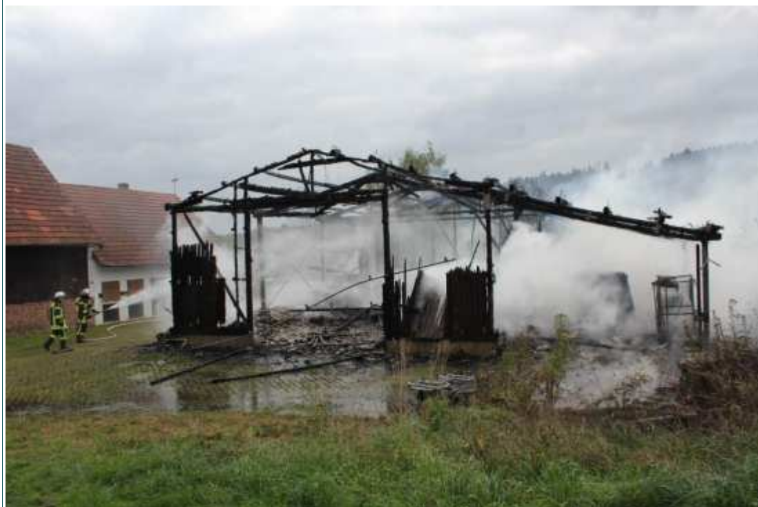
Nur noch ein Gerippe ließ am Montagnachmittag ein Großbrand von einer Scheune in Unter-Mossau übrig. Foto: Dieter Berlieb
